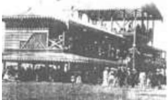
Figura 1 - Pavilhões de madeira anteriores às construções atuais.
